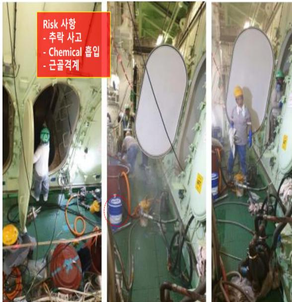
Chamber 내부 Cleaning 작업 시 전도사고 위험 및 Chemical 노출
