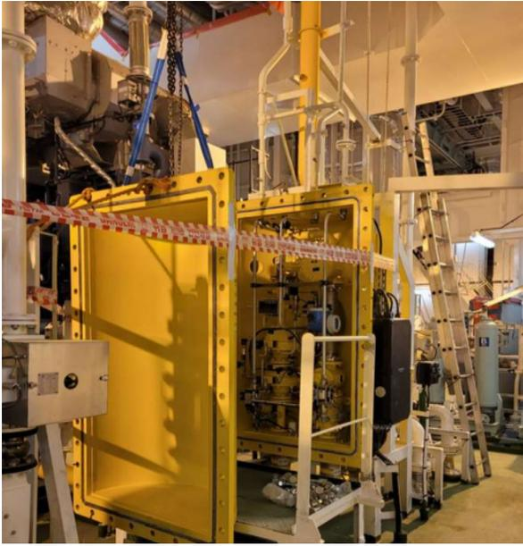
GRU 커버 개폐 시 체인블록 사용이 필수적이며, 중량물 이동 및 고소작업으로 인한 안전사고 발생 위험
