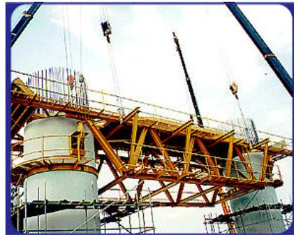
[그림 3-9] 코핑부에 설치된 거푸집 및 작업발판의 전경
