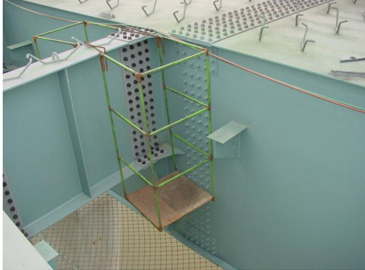
[그림 3-27] 강교량 가로보에 설치된 달대비계의 전경
