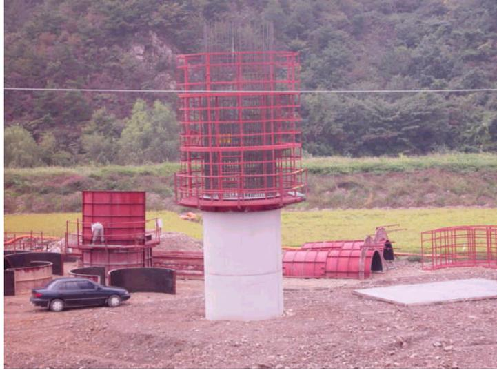
[그림 3-5] 철근 조립용 작업발판의 설치 전경
