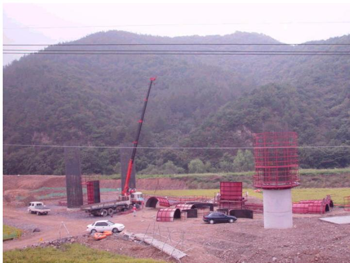
[그림 3-7] 거푸집 설치·해체를 위한 크레인 작업 전경
