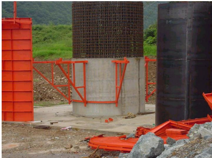
[그림 3-4] 두 번째 롯데의 거푸집 설치용 브래킷 설치 전경
