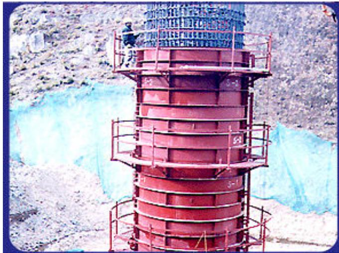
[그림 3-8] 강재 거푸집의 설치 전경
