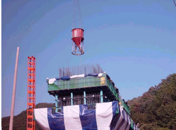
[그림 3-15] 콘크리트 타설용 기구의 권상 전경
