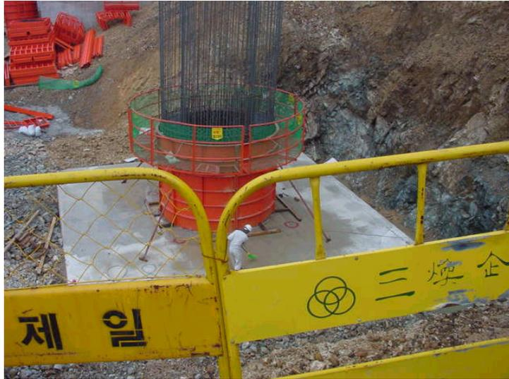
[그림 3-3] 기초판 위 첫 롯데의 강제 거푸집 설치 전경
