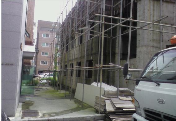
[그림 6-10] 중소건설현장의 위반실태 (작업발판 미설치, 밀동잡이 미설치, 교차가새 미설치, 비계수 직도 맞지 않음, 안전난간 미설치, 발끝막이판 미설치, 자재 적치상태 불량 등)
