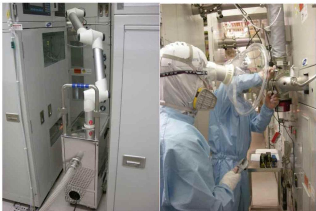
[그림 2-10] PM작업 시 이동식 국소배기장치 사용모습(예)
