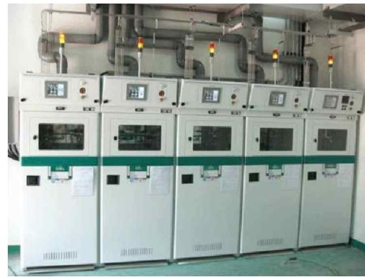
[그림 2-22] 가스 공급장치(Gas Cabinet System)
