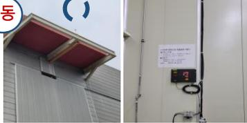
Hoist Beam 상부에 풍속계 설치
