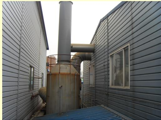
[그림 III-10] 집진기 추가 설치(2대)
