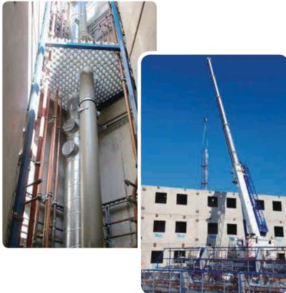
시공사는 해당 위험에 대해 정확하게 파악을 하였고 이를 해결하고자 공사 현장 밖에서 파이프 작업을 한 뒤, 간단하게 설치할 수 있도록 설계함. 파이프와 고정 프레임 연결 등 대부분의 공정을 먼저 완료한 뒤 완성된 프레임을 현장으로 운반하고, 크레인으로 설치하기까지 위험 요소들을 모두 고려하여 작업이 이루어짐. 이를 바탕으로 노동자들의 근골격계 질환 위험을 없애고, 추가적으로 분진 및 진동, 소음으로부터 보호할 수 있었음
