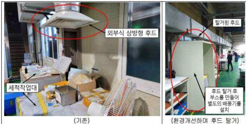
[그림 II-15] 세 번째 사업장 - 국소배기후드 불량과 미설치
