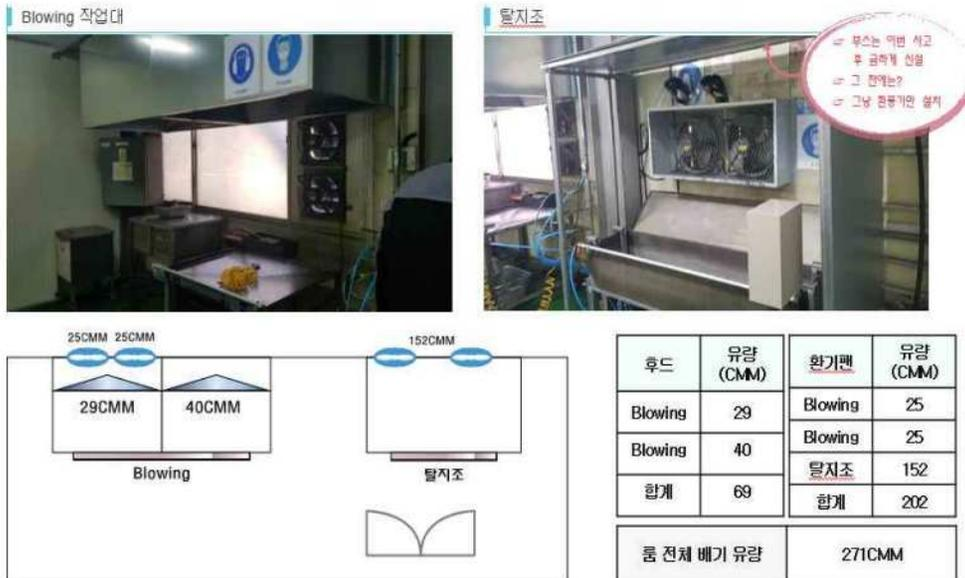
[그림 II-13] 첫 번째 사업장 - 환풍기에 의한 환기(국소배기장치 미설치 판정)
