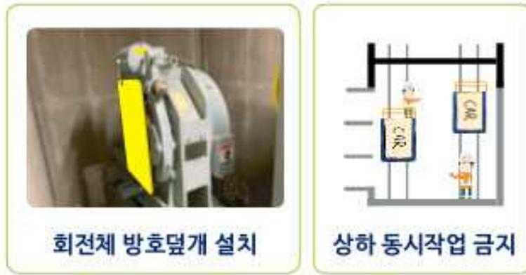
[그림 II-22] 엘리베이터 안전 장치 및 작업조건 예시
